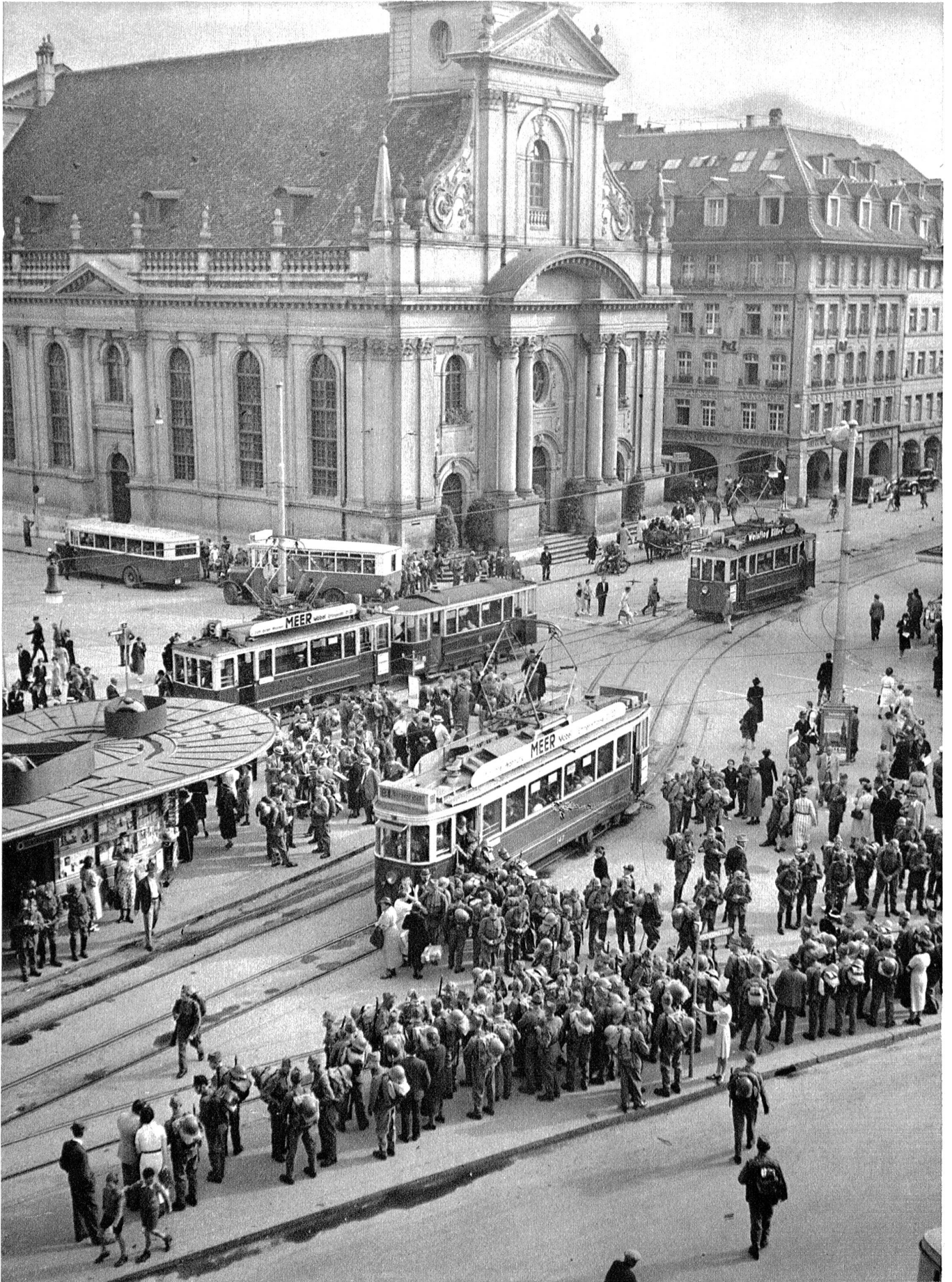
1. Mobilisationstag auf dem Bahnhofplatz in Bern. Alle Verkehrsmittel, Tram und Autobus, stehen zur Verfügung, um die eingerückten Wehrmänner an ihre Sammelplätze zu bringen. (Photo Senn).
