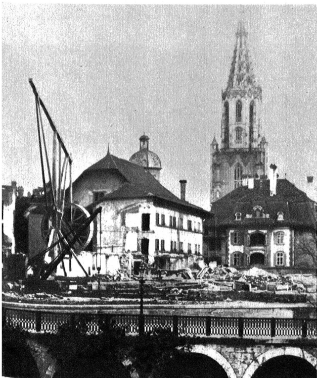
Abbruch einst und jetzt: Beim Abbruch der Aula der alten Hochschule im Jahre 1908 wurde noch ein Tretrad-Kran verwendet, der meistens durch Sträflinge betrieben wurde, während der moderne Kran durch elektrische Kraft ein mehrfaches der früheren Maschinen leistet.
