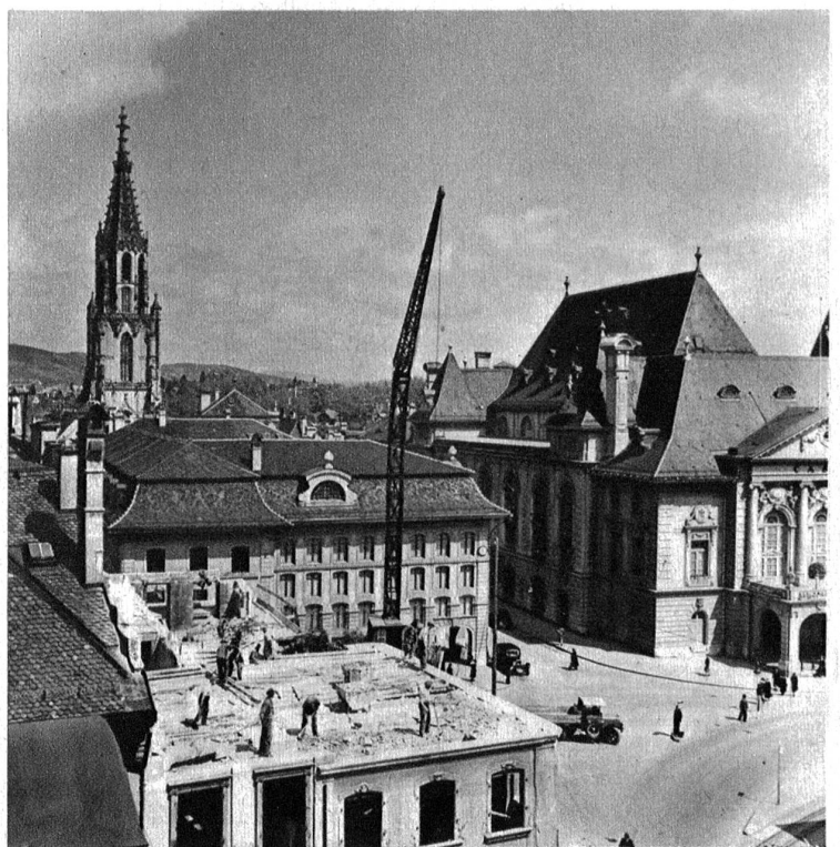
Abbruch einst und jetzt: Beim Abbruch der Aula der alten Hochschule im Jahre 1908 wurde noch ein Tretrad-Kran verwendet, der meistens durch Sträflinge betrieben wurde, während der moderne Kran durch elektrische Kraft ein mehrfaches der früheren Maschinen leistet.
