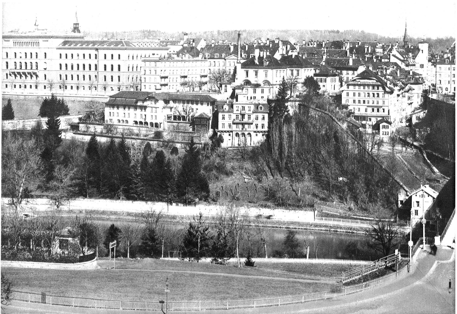
Stadtansicht um 1900 vom Historischen Museum auf dem Kirchenfeld aus. Die Brücke erscheint durch die Hochschule (Aula) wie versperrt. Der westliche Brückenausgang gegen den heutigen Kasinoplatz hiess damals noch Aulastrasse. Westlich vom Gerbergraben die ehemalige Münze, daran anschließend das ehemalige Hallerhaus und das alte Bellevue.
