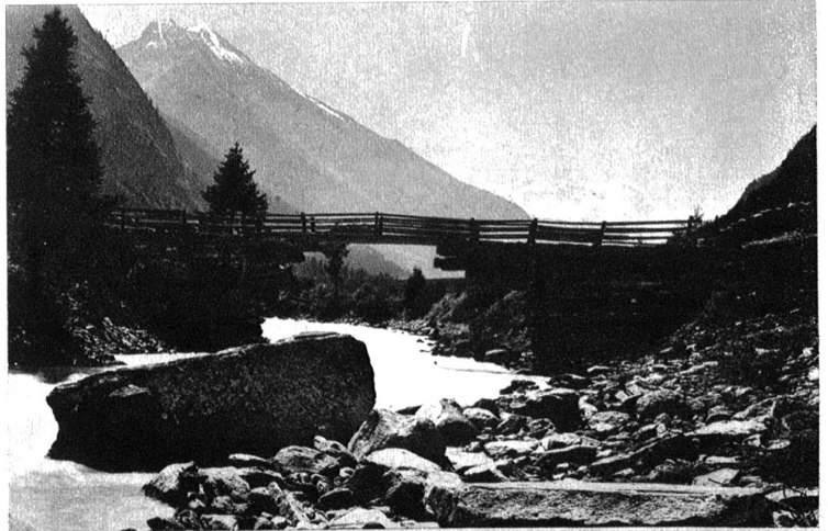
Brücke auf Endpfeilern ruhend, die aus überragenden Stämmen aufgebaut sind. Brücke bei Randa im Zermattetal. Im Hintergrund das Breithorn.
