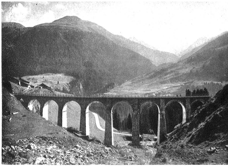
Bugnei-Viadukt bei Sedrun (Bündner Oberland). Phot. Schnegg
