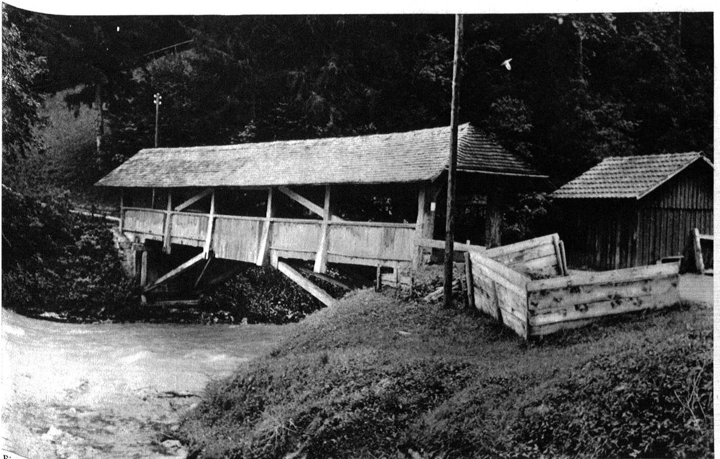
Einfache gedeckte Holzbrücke bei Weissenburg im Simmental. (Die grossen Holzbrücken des Bernerlandes sollen später gesondert zur Darstellung kommen). Phot. Schäfer.
