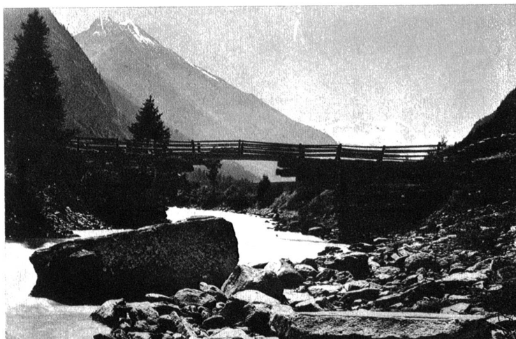
Brücke auf Endpfelern ruhend, die aus überragenden Stämmen aufgebaut sind. Brücke bei Randa im Zermattetal. Im Hintergrund das Breithorn.
