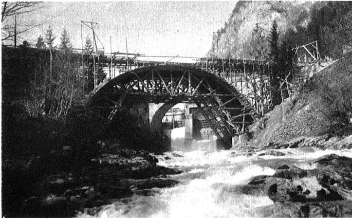
Die neue Simmenbrücke. In Port bei Wimmis wird gegenwärtig eine neue Brücke gebaut. Die Photo zeigt das Leergerüst. Daneben steht die alte Brücke mit der Jahrzahl 1766 und im Hintergrund das Simmenstauwehr.
