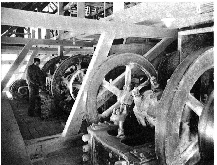
Brechanlage für die mechanische Zerkleinerung des Rohmaterials.
