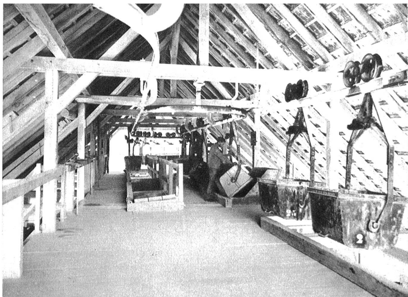
Die Seilbahn, welche das Rohmaterial aus den beiden Steinbrüchen bis zur Fabrik befördert.
