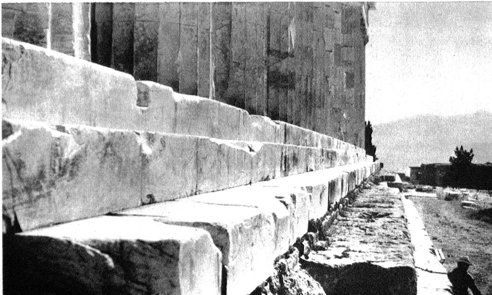
Parthenon. Die drei Marmorstufen über dem hohen Südfundament. Kaum sichtbar und doch so wirksam ist die schwache Krümmung aller Linien.
