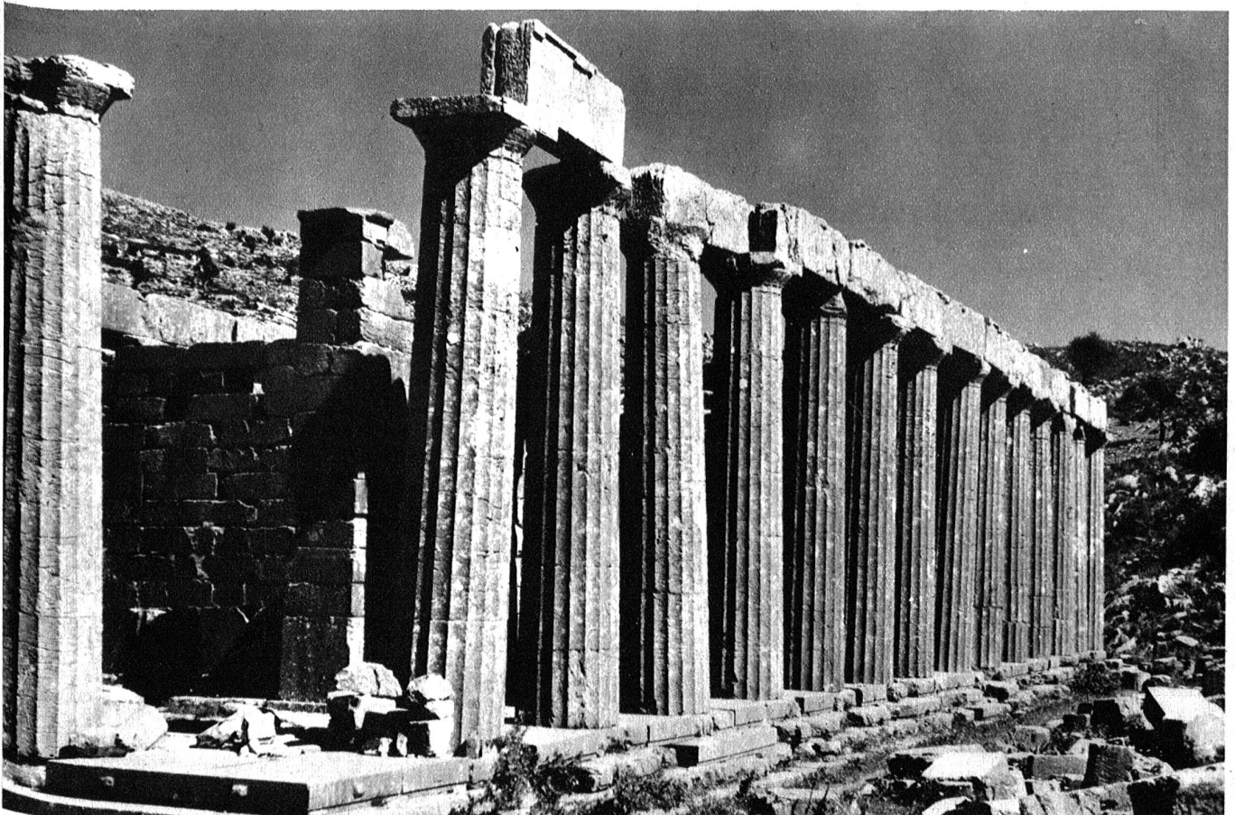
Eine stolze Reihe, wenn auch einige durch Erdbeben schief stehen. Der dorische Säulengang des Apollotempels von Bassae.
