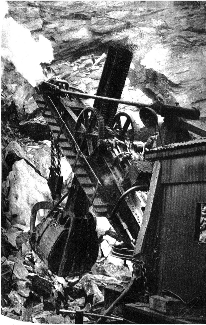
Mit grossen und starken Greifern werden die abgesprengten Gesteinsbrocken gefasst und in die bereitstehenden Kippwagen gehoben.
