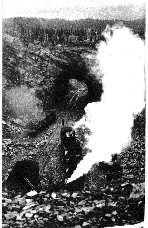
So bauen die Menschen am Berg, graben tiefe Löcher, sprengen ein Stück nach dem andern weg, bis eines Tages der ganze Berg abgetragen sein wird, denn seine Felsen bergen das in unsern Tagen so kostbare Eisenerz.
