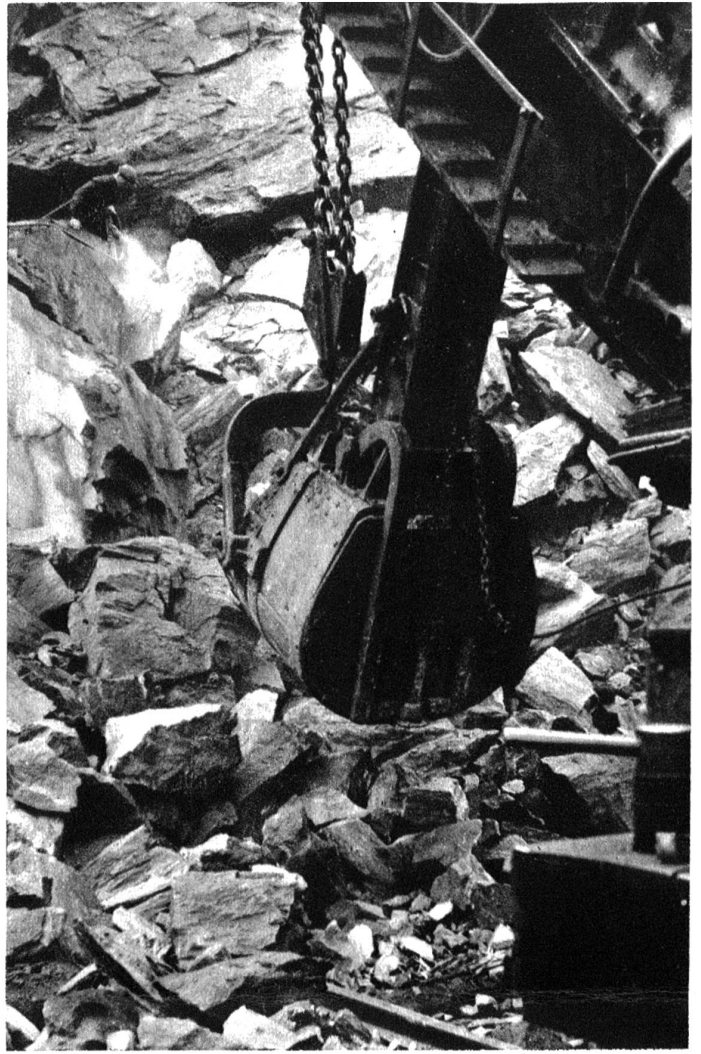
Der starke Greifer an der Arbeit. Müheless hebt er die eisenschweren Gesteinsbrocken in die Kippwagen. Mit seinen eisernen Fingern greift er in Ritzen und Spalten und vollendet der Sprengung wuchtiges Werk.
