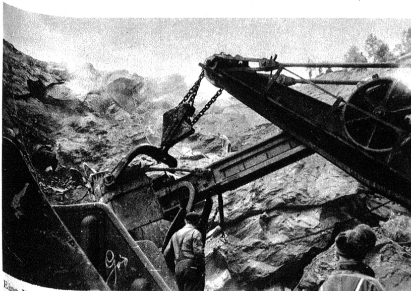
Mit grossen und starken Greifern werden die abgesprengten Gesteinsbrocken gefasst und in die bereitstehenden Kippwagen gehoben.
