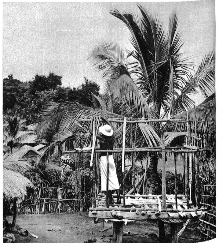
Jeder baut sich sein Haus selbst. Einige Pfähle werden eingerammt und darauf entsteht ein Geflecht aus Bambus. Die Palmen liefern das Dach. Mehr braucht es nicht. Um sich vor der gleissenden Sonnenhitze zu schützen, trägt der „Bauherr“ einen weitrandigen Schattenhut aus Reisstroh.
