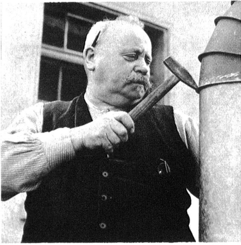
Der Spenglermeister am Ventilationsrohr.
