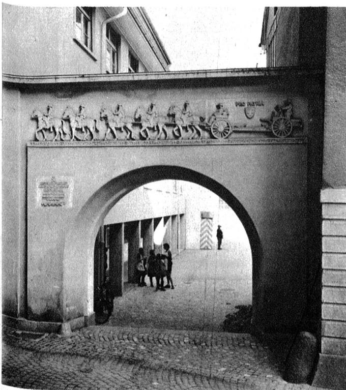
Salzhaustorbogen mit der Bundesrat Scheurer-Gedenktafel. Das Relief, eine bespannte Feldhaubitze, erinnert an den Auszug der Feldhaubitzeabteilung 27 aus Wangen im Jahre 1914, unter ihrem ersten Kommandanten Oberstleutnant Scheurer. Ausgeführt von Bildhauer Huggler.
