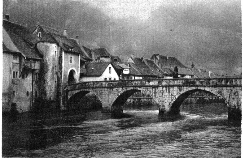
Brücke über den Doubs mit Nepomukstatue, erbaut 1728/29.
