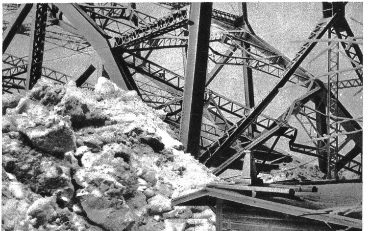
Die Eismassen an den Fundamenten der Brücke
