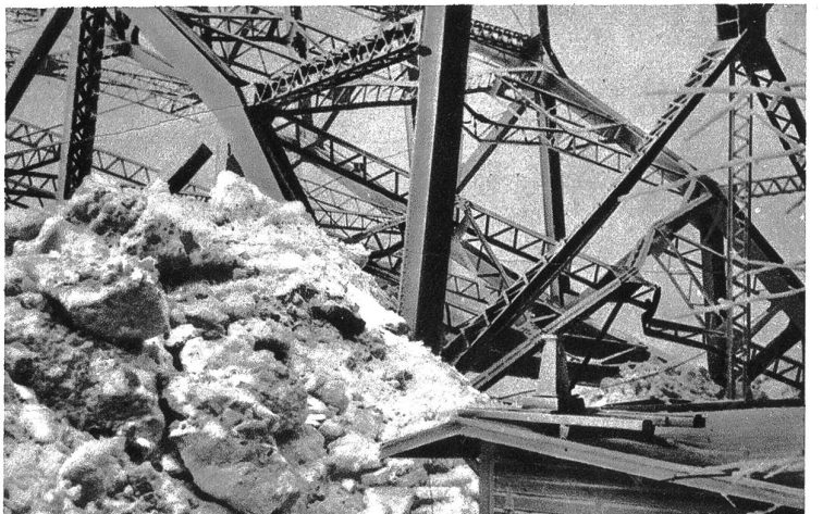
Die Eismassen an den Fundamenten der Brücke
