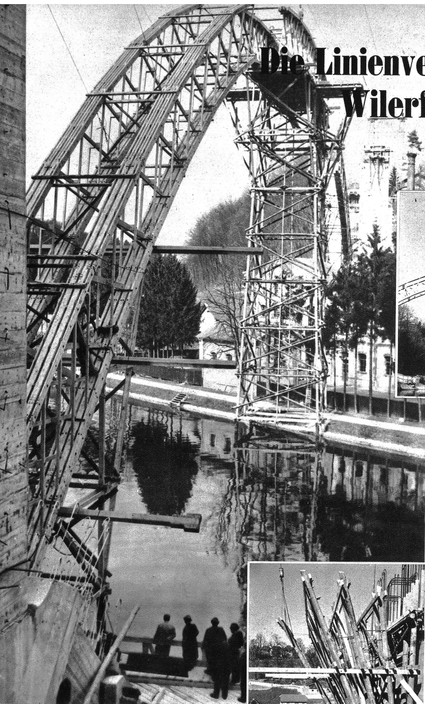
Der grosse Brückenbogen in der Konstruktion
