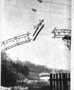
Ein Sektor des Brückenbogens wird mit Kranen eingesetzt
