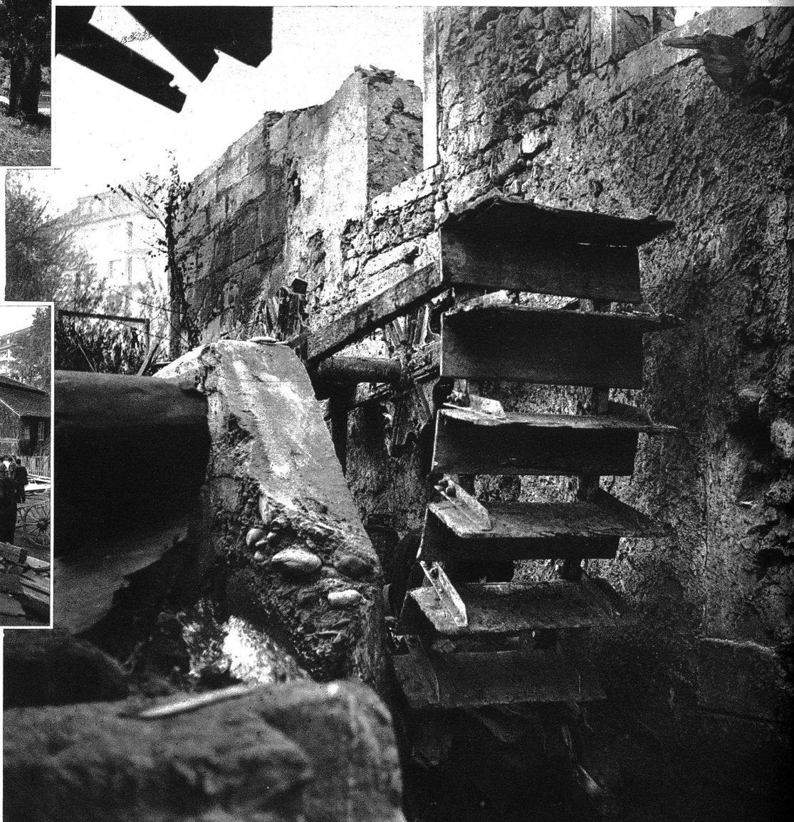
Ausgedient! Das alte eichene Wasserrad im Abbruch.
