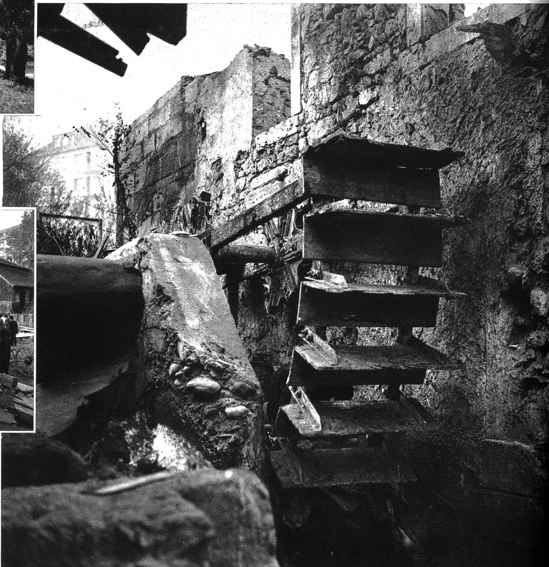
Ausgedient! Das alte eichene Wasserrad im Abbruch.
