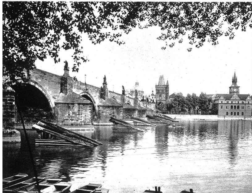
Karlsbrücke in Prag. Die schönste Brücke der ganzen Welt. — 1357 von Karl IV. gegründet. An dieser Stelle stand eine uralte hölzerne Brücke, die 1169 durch eine steinerne ersetzt wurde, die aber den elementaren Moldaufluten nicht standhielt. Sie ist 520 Meter lang, 10 Meter breit, 17 Pfeiler, bogenförmig gegen die Strömung ausgebuchtet. Mit der Ausschmückung begann man erst im 18. Jahrhundert.
