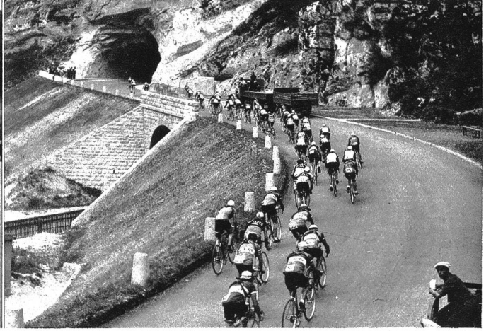
Das Feld passiert die neue Bahnüberführung bei Sonceboz, im Aufstieg zum Pierre-Pertuis-Pass.
