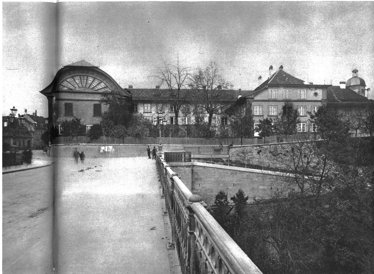
So um die Jahre 1890 befand sich die Universität Bern am Platze des heutigen Kasinos. Das grosse Gebäude links war die Aula, in der Mitte das Kolleg. Der Turm rechts im Bilde dokumentiert die „Grüne Schule“, genannt auch Kantonschule oder das heutige Gymnasium. Alles ist abgerissen. An diesem Platz steht heute das . . .
