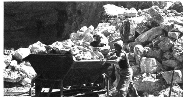
Das Bruchmaterial wird in Rollwagen in die Zementfabrik gerollt.
