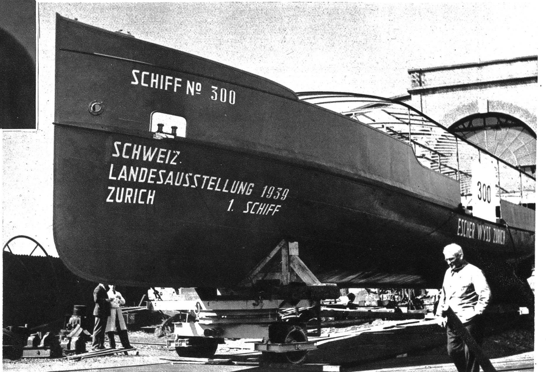
Das 1. Landesausstellungsschiff, das während der Ausstellung den Personenverkehr über den Zürichsee bewältigen wird, hat die Werft verlassen und wird am Montag durch die Stadt Zürich zum See gezogen. Es ist das 300. Schiff, das in den Escher-Wyss-Werkstätten erbaut wurde. Die Firma blickt gleichzeitig auf 100 Jahre Schiffbau zurück. Photopress.
