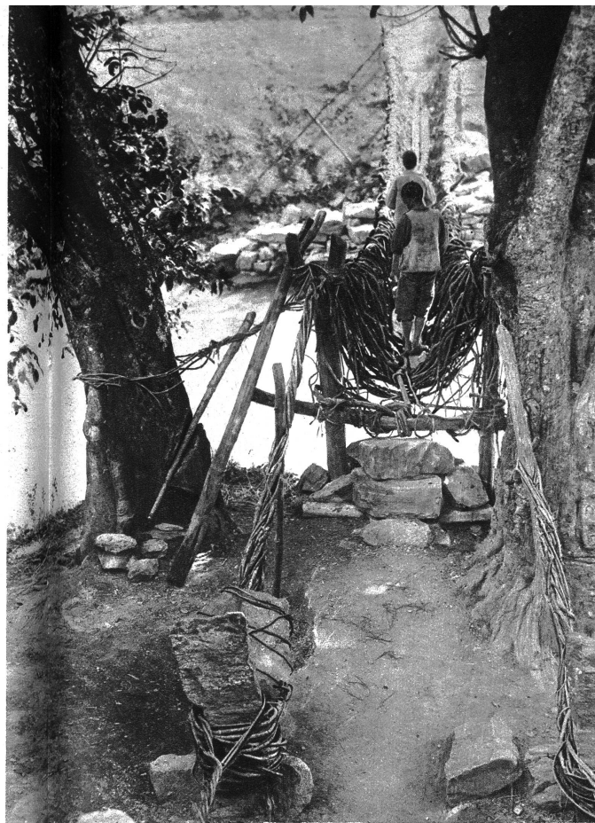
Primitive, aus Lianengewächsen geflochtene Brücke in China.
