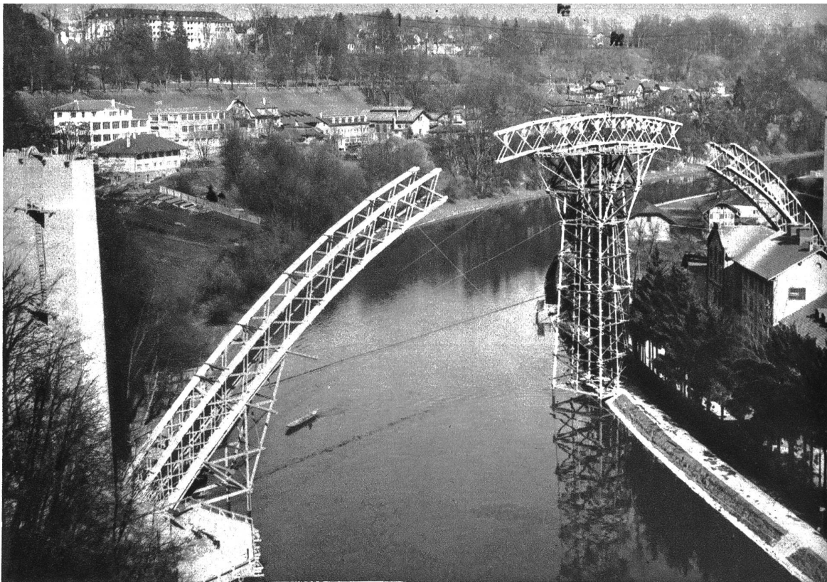
Eine Eisenbahnbrücke über die Aare in Bern. Die Bauarbeiten für die Erstellung der Lorraine-Zufahrt zum Berner Bahnhof schreiten rasch vorwärts. Nachdem im Lorrainequartier schon seit einiger Zeit Viaduktbauten entstanden sind, ist nunmehr auch das imposante Brückengerüst über die Aare in Angriff genommen worden. Wir zeigen das Gerüst des zukünftigen Bahntracés über die Aare in Bern.
