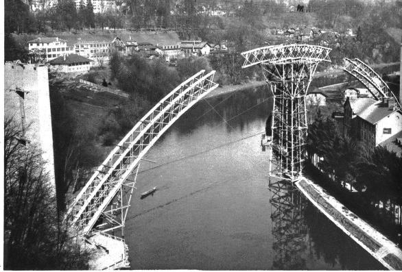
Eine Eisenbahnbrücke über die Aare in Bern. Die Bauarbeiten für die Erstellung der Lorraine-Zufahrt zum Berner Bahnhof schreiten rasch vorwärts. Nachdem im Lorrainequartier schon seit einiger Zeit Viaduktbauten entstanden sind, ist nunmehr auch das imposante Brückengerüst über die Aare in Angriff genommen worden. Wir zeigen das Gerüst des zukünftigen Bahntracés über die Aare in Bern.
