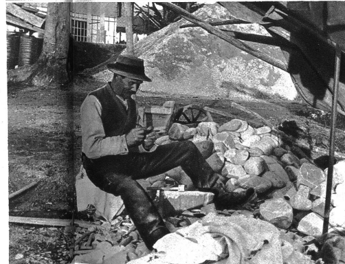
Steine für die Böschung werden hergerichtet
