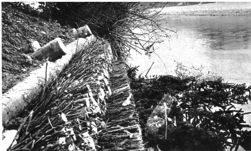
Die einzelnen Lagen von Holz werden verankert und quer abgedeckt
