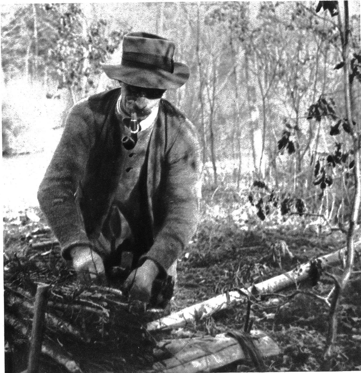
Binden der Wedeln für die Verbauung
