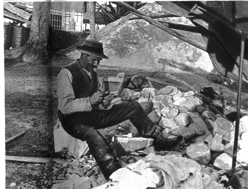
Steine für die Böschung werden hergerichtet
