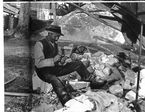
Steine für die Böschung werden hergerichtet
