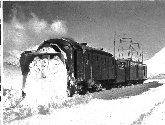
Dampfschneeschleuder der Berninabahn auf Berninapasshöhe, 2300 Meter. Dampfschleuder 600 PS, elektr. Lokomotive 700 PS, manchmal werden 3 Lokomotiven neben der Dampfschneeschleuder verwendet, also total ca. 3000 PS.
