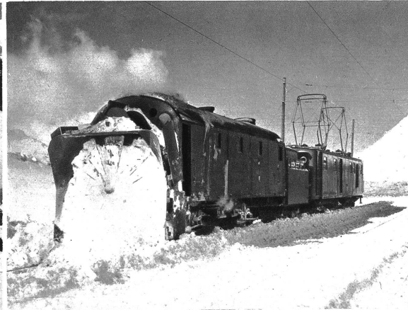
Dampfschneesleuder der Berninabahn auf Berninapasshöhe, 2300 Meter. Dampfschleuder 600 PS, elektr. Lokomotive 700 PS, manchmal werden 3 Lokomotiven neben der Dampfschneesleuder verwendet, also total ca. 3000 PS.
