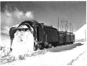
Dampfschneeschleuder der Berninabahn auf Berninapasshöhe, 2300 Meter. Dampfschleuder 600 PS, elektr. Lokomotive 700 PS, machmal werden 3 Lokomotiven neben der Dampfschneeschleuder verwendet, also total ca. 3000 PS.
