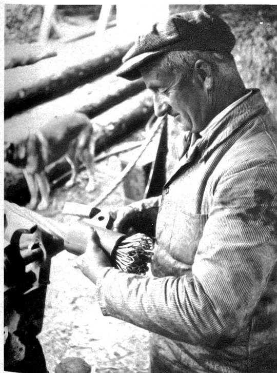
Der Seilkopf ist eingespannt; jeder Draht wird nun umgebogen, um ein Ausgleiten zu vermeiden
