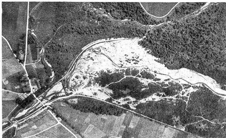
Grosser Ablagerungsplatz der Gürbe unterhalb der Blumensteinbrücke. Links: Brücke bei der Säge. (Flugbild der Eidg. Landestopographie.)
