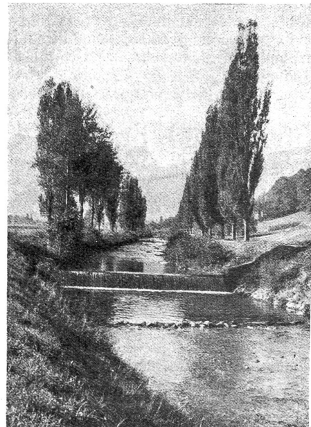
Der Gürbekanal oberhalb Pfandersmatt.
