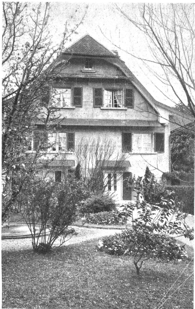
Das Stürler-Spital des Diakonissenhauses Bern an der Altenbergstrasse.
