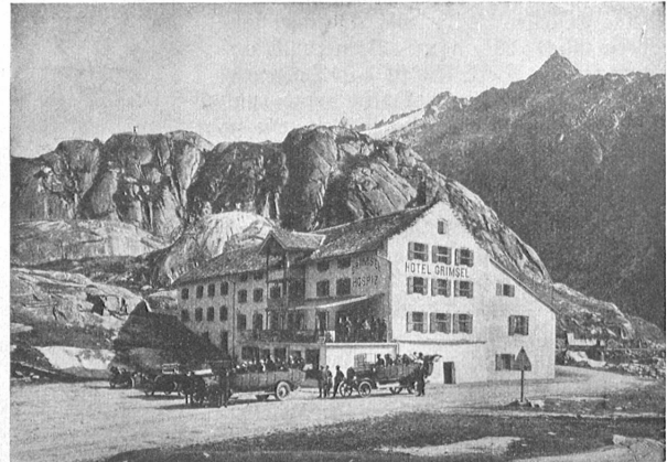
Das alte Grimsel-Hospiz, das nun unter Wasser liegt.
