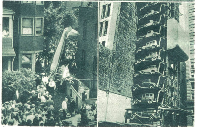
Ein Flugzeug stürzt in ein Haus. In Cleveland (Nordamerika) stürzte ein Flugzeug in ein Haus und verletzte ein im Zimmer sitzende Bewohnerin schwer. Eine neue Parkmaschine in Chicago. Auf dem Platz, den man gewöhnlich für 6 Wagen braucht, können 48 Wagen parken, indem sie mit Hilfe eines Elevators in Etappen übereinander gestellt werden.
