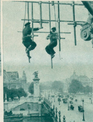
Pariser Luftkrobaten. Arbeiter beim Wiedervergolden der Statuen auf der Alexanderbrücke. Im Hintergrund das große und das kleine Palais. Photo Keystone View Co.
