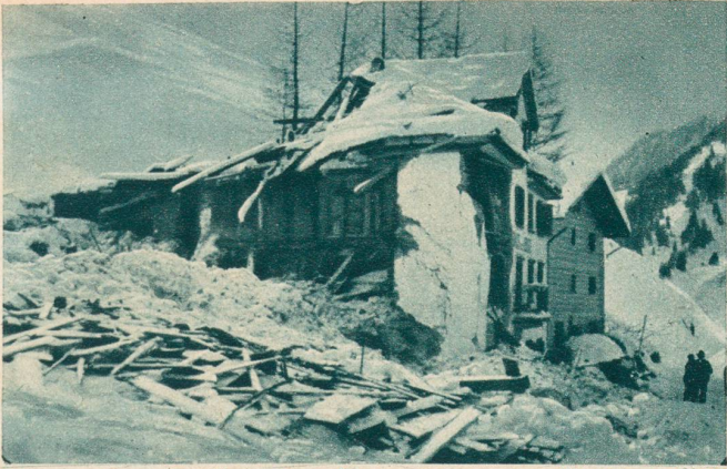
Das zerstörte Gasthaus «zur Post».
