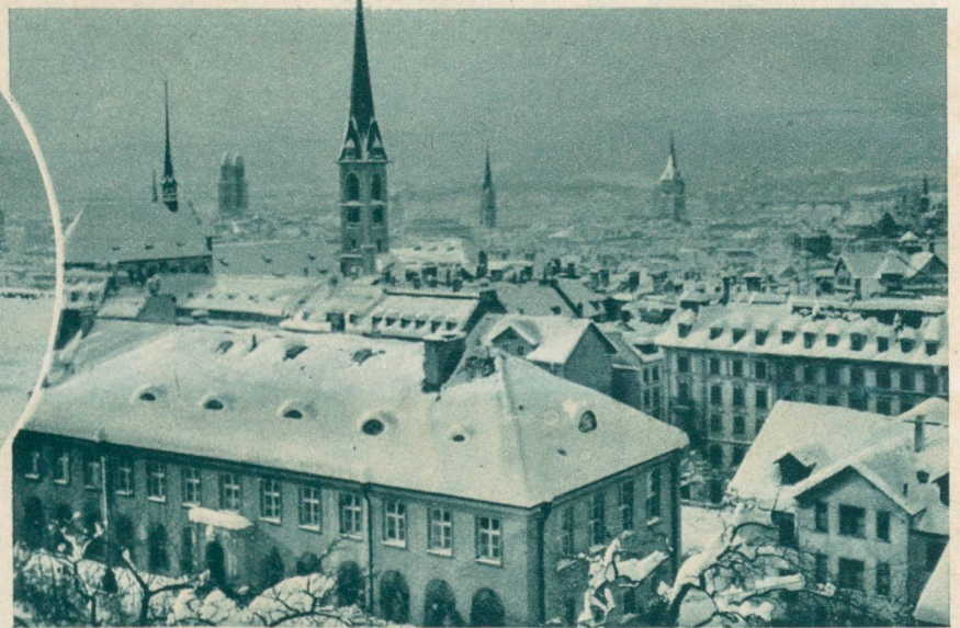
Die Stadt am Morgen des 11. März 1931. Phot. A. Krenn, Zürich
