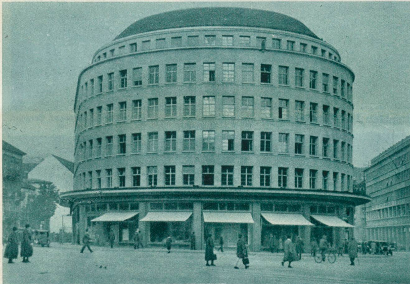
Das neue Geschäftshaus zum «Schmidhof», Ecke Sihl- und Löwenstraße.
