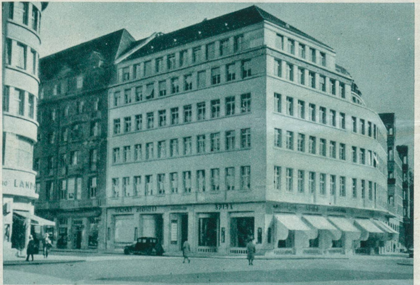
Das neue Geschäftshaus zum «Bako» an der Sihlstrasse.
