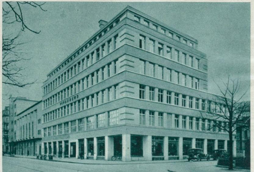
Das neue Geschäftshaus zum «Titan» an der Stauffacherstrasse.
