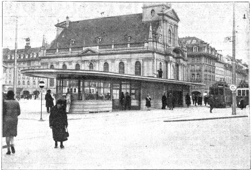
Das neue Tramstationsgebäude und der Bubenberglplatz. (Phot. D. Rohrer.)
