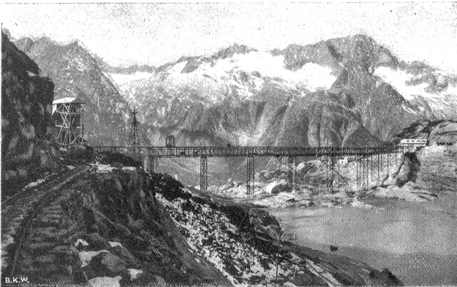
Gelmerperre. Blick auf Betonierbrücke über dem Gelmerkragen. Links Betonieranlage, rechts Logierhaus.
