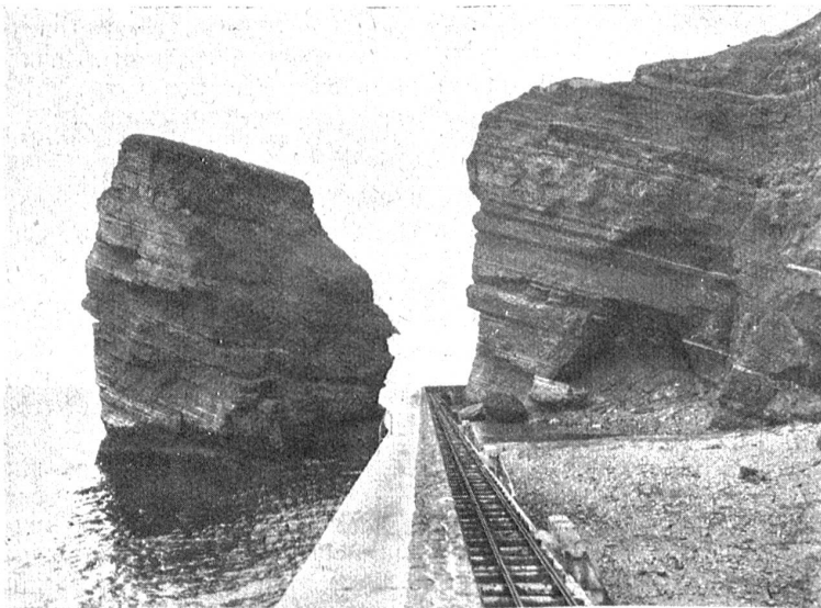
Helgoland. Ein Teil der fertiggestellten Mauer, welche zwischen der Küste und einem vom Meere fortgerissenen Selsblock durchführt.
