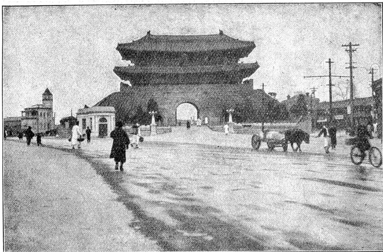
Das alte Tor von Kejo nach dem Abbruch der Mauer.
