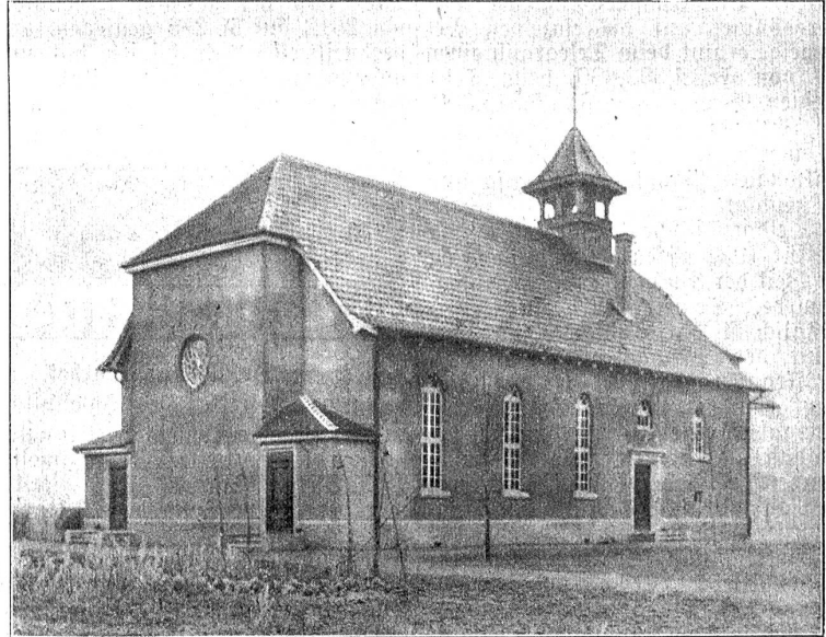
Gemeindefhaus in Strättligen bei Thun.
