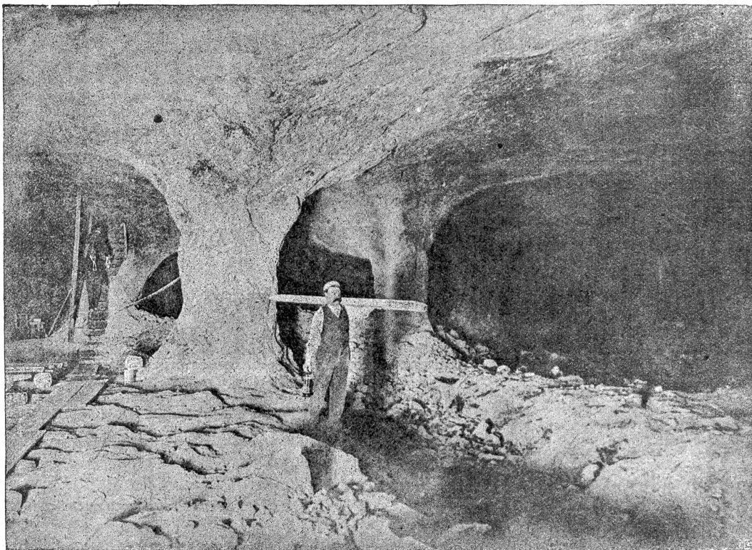
Die Salinen von Bex: Galerie von Coulat. Im Hintergrund steigt eine Treppe zum obern Stockwerk empor.
