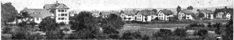
Arbeiterhäuser in Gerlafingen.
