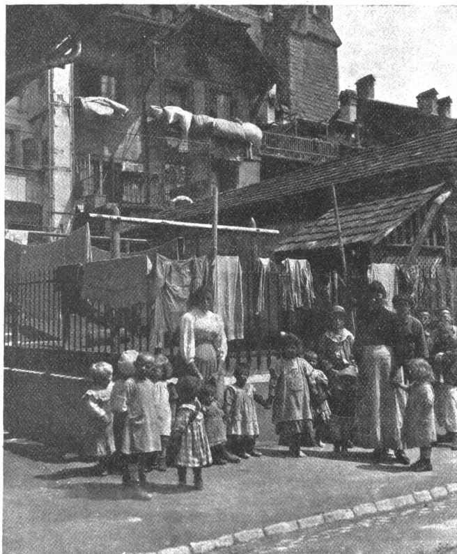
Häuser an der Badgasse in Bern mit Blick auf die Aarestrasse. 2)
