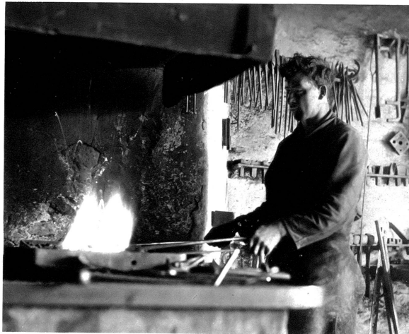
Das Eisen wird zum Fertig anpassen ins Feuer gelegt und in die genaue Form geschmiedet
