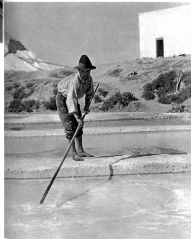
In den Salzärten wird das Meerwasser so lange der Sonne ausgesetzt, bis es verdunstet ist und das Salz übrig bleibt
