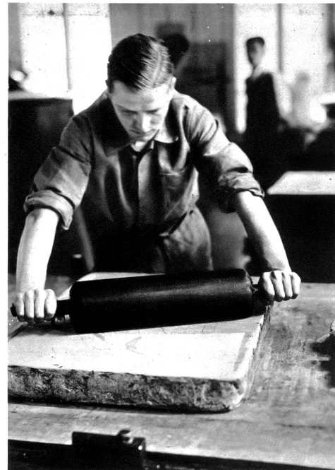
Der Stein wird eingefärbt um Probeabzüge herzustellen
