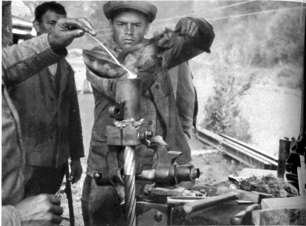
Der Seilkopf wird ausgegossen
