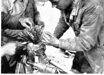
Der Seilkopf ist eingespannt; jeder Draht wird nun umgebogen, um ein Ausgleiten zu vermeiden
