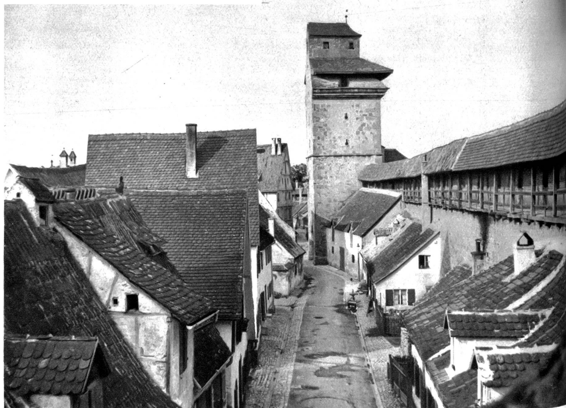
Alter Befestigungsturm in Sulzfeld am Main, baulich bemerkenswert durch die aus der Haube vorspringenden Erkerbauten
