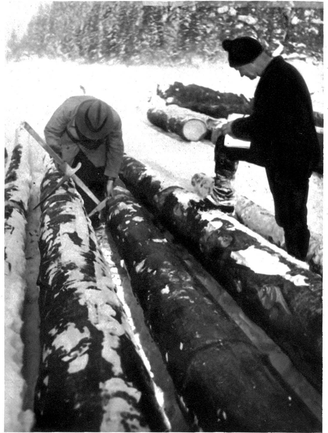
Zahlreiche Kubikmeter Laden sind auf den Sägereien aufgestapelt. Mit der Messkupe wird der Durchmesser eines einzelnen Stammes ermittelt. Es gibt Bauern, die über 100 Stämme in die Sägereien liefern
