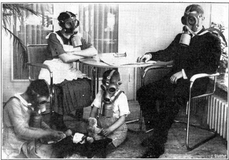
größern Rahmen besprochen werden Eine ganze Familie, die mit Gasmasken einer neuen Konstruktion ausgestattet ist. Die Masfönnten, aber nur in einem größern Rah- ken sind besonders leicht und üben keinerlei Druck auf den Kopf aus.
