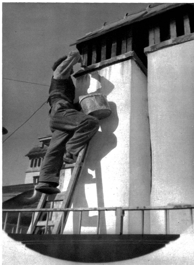
Auf wankendem Steg muss am hohen Kamin der Mörtel angebracht werden
