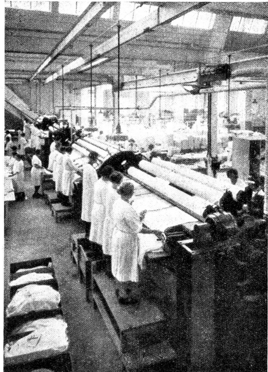
Vier große Bügelmaschinen für Flachwäsche.
