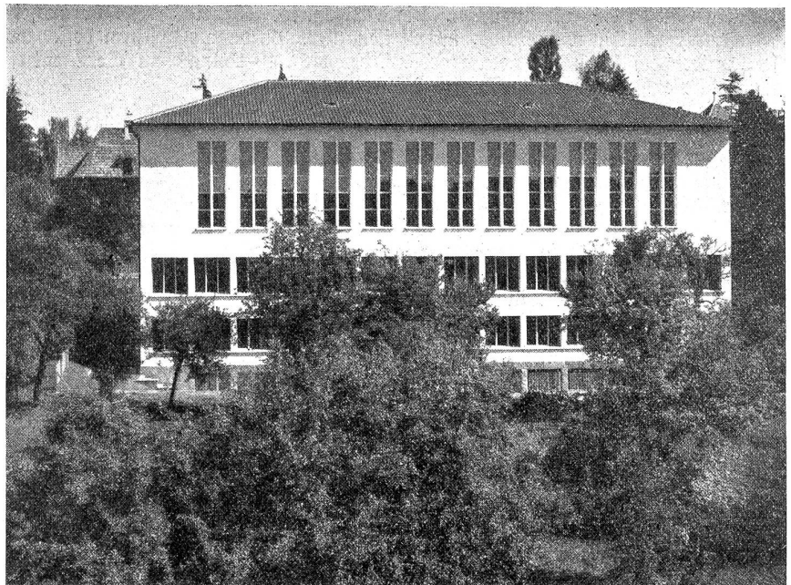
Kirchgemeindehaus Johannes. Westfassade.
