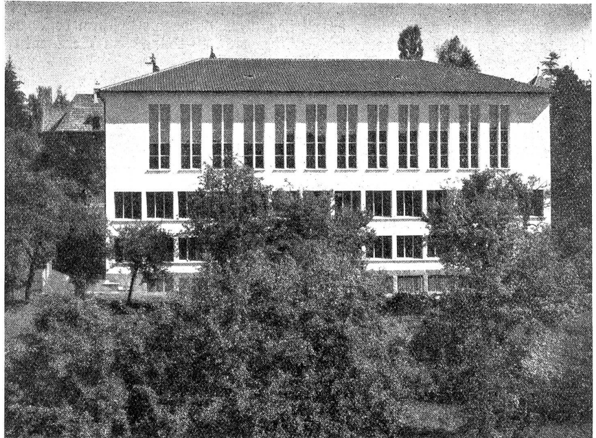
Kirchgemeindehaus Johannes. Westfassade.
