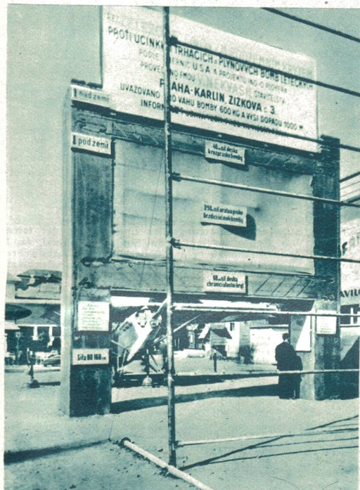
Die bombenfeste Deckenkonstruktion. Ein Prager Bau-Unternehmen hat eine Wand- und Decken-Konstruktion fertiggestellt, die jedem Bombeneinschlag standhalten soll. Sie besteht aus einem oberen Balken von 40 cm und einem unteren Balken v. 60 cm Dicke, zwischen denen sich eine 2,50 m breite Sandschicht befindet. Bei einem Bombeneinschlag zersplittert der Oberbalken, aber die Explosion wird im Sand erstickt, und der Raum unter dem Unterbalken bleibt ungefährdet. Die Konstruktion sichert gegen Bomben, die ein Gewicht bis 600 Kilogramm haben können und aus einer Höhe bis zu 1000 m abgeworfen werden. — Wäre es für die Grossmächte nicht besser, durch eine internationale Verständigung und aufrichtige Abrüstungs-Konvention sich die Bomben auch ohne Balken vom Hals zu halten? (Wide World)
